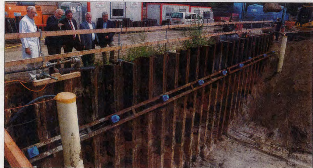
An der Baugrube: Ernst Röttger (v. l.), Wilhelm Wolken, Reinhard Winter, Dietmar Blank und Bernd-Carsten Hiebing unterhalten sich über den Baufortschritt am neuen Bettenhaus.
