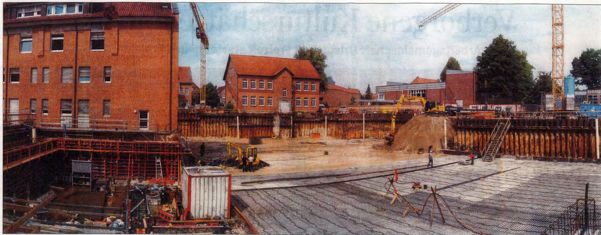
Acht Meter tief ist die Baustelle am Krankenhaus Ludmillenstift. Gebaut wird an allen Ecken und Enden. In der Bildmitte die ehemalige Altstadtsschule.
