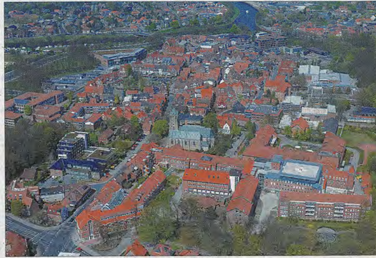
Das Krankenhaus Ludmillenstift (vorn im Bild): Mit einer erneuten Bau- und Umbaumaßnahme soll das Angebot für die Patienten verbessert werden. Foto: Ludmillenstift
